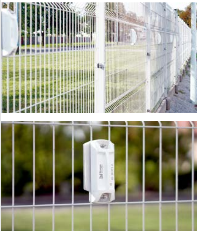
Fot. 1. Przykład montażu detektorów systemu. Źródło: materiały RCS
