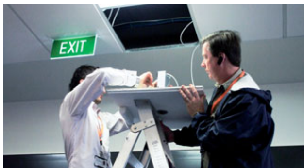
Fot. 2. Montaż systemu znakującego jest bardzo łatwy i szybki
